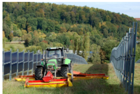
Mäharbeiten zwischen den senkrechten Modulen. Foto: Next2Sun GmbH
